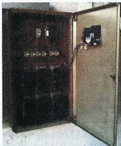
Figura 6.61. Cuadro eléctrico industrial destinado a la compensación del factor de potencia.
